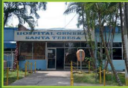
Hospital Regional Santa Teresa, Comayagua, Honduras.
