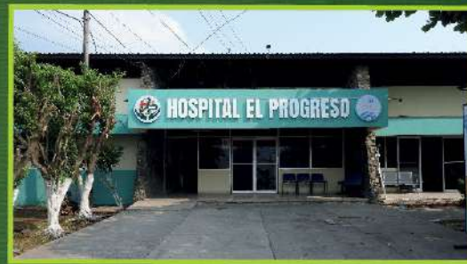
Hospital El Progreso, El Progreso, Yoro, Honduras.
